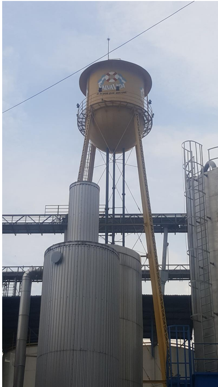
Ilustración 28. Tanque elevado de agua (planta de cerveza)
