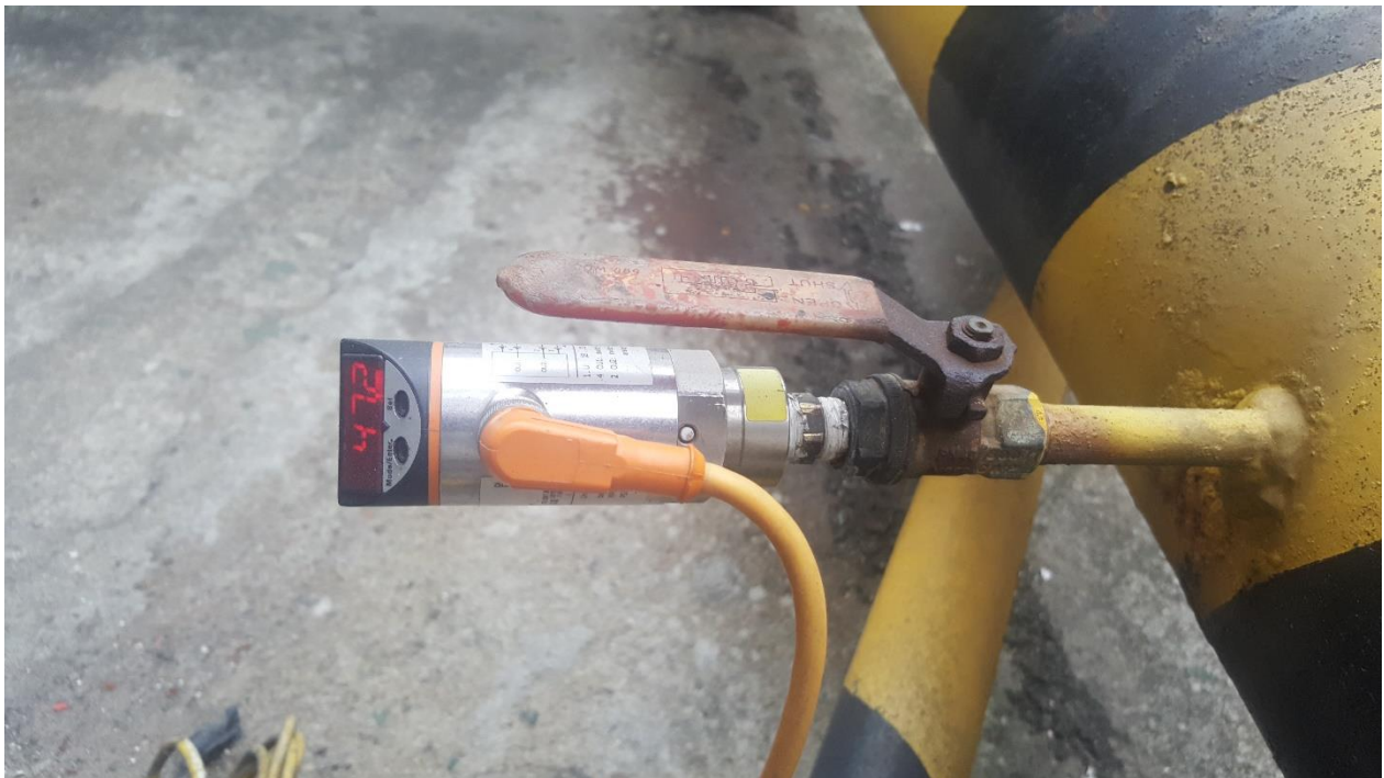
Ilustración 27. Instalación del transductor de presión
