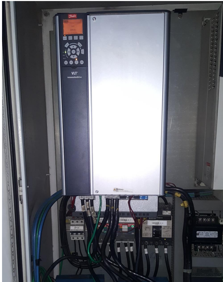
Ilustración 24 – Instalación del nuevo variador
