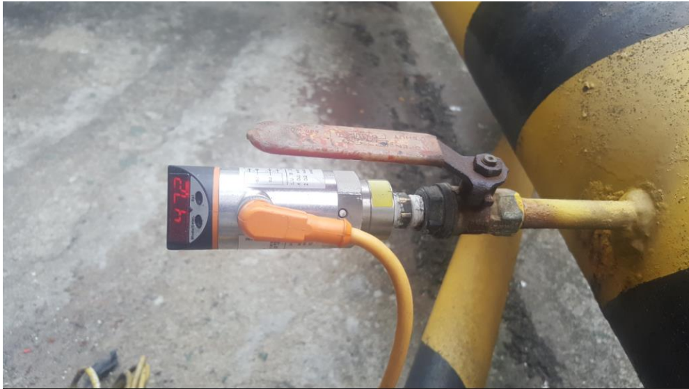
Ilustración 18. Instalación del transductor de presión ifm PN2224
