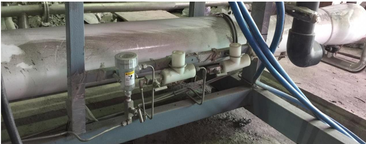
Anexos 29. Base para sensores de pH, conductividad y temperatura en área de ósmosis inversa
