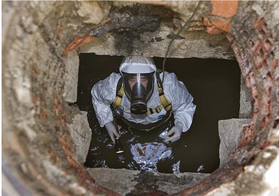
Figura 3. PERSONA TRABAJANDO EN ALCANTARILLA.
