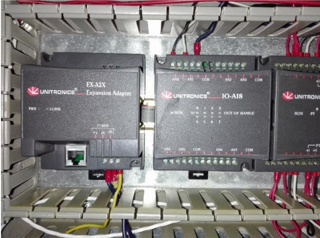
**Ilustración 20. Módulos IO's para RTD pt100**
