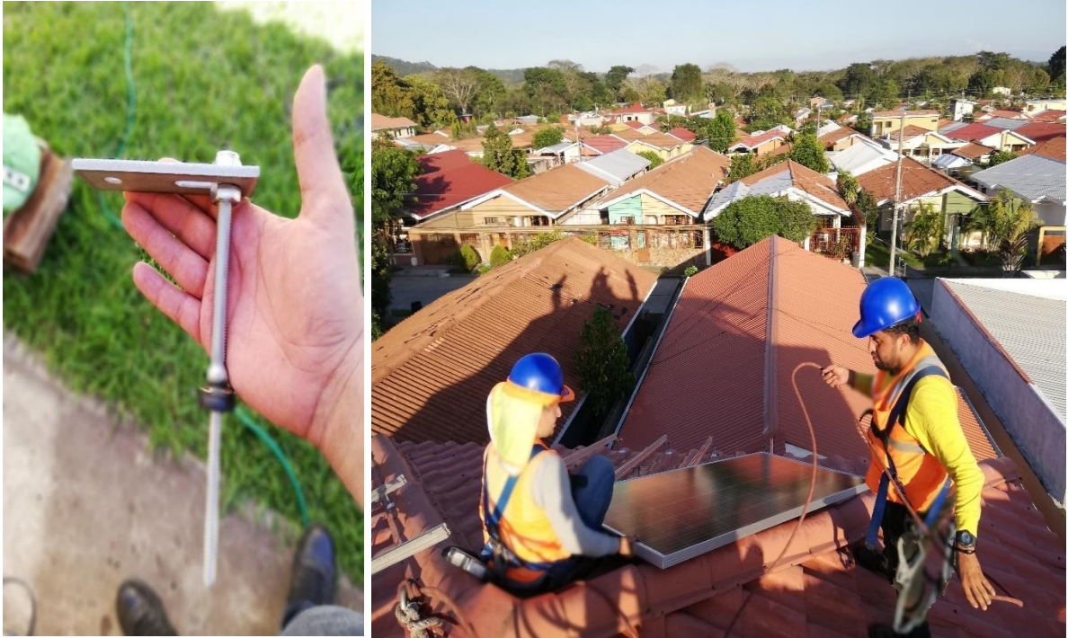
Ilustración 15 Anclaje al techo e instalación de módulos fotovoltaicos.
