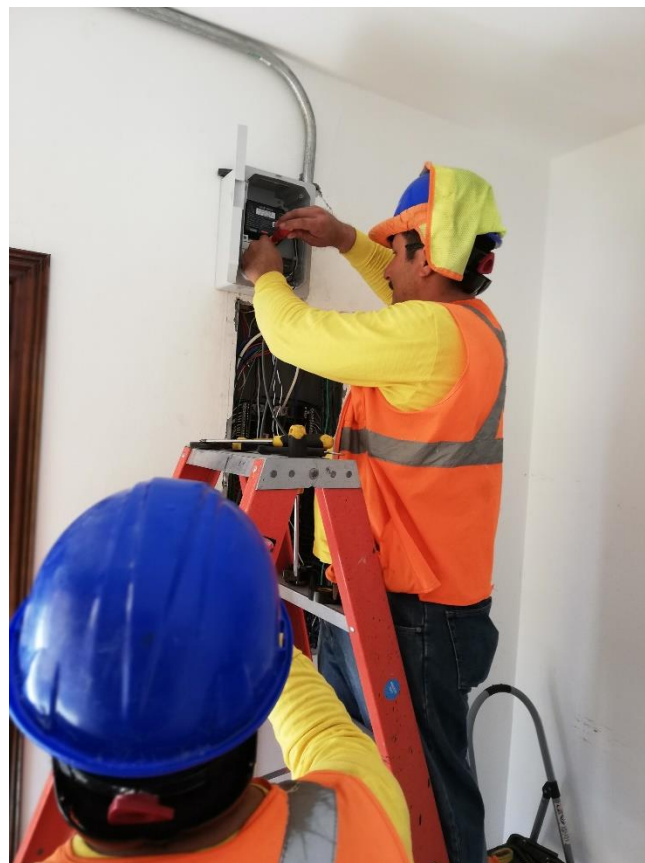
Ilustración 16 Interconexión del sistema fotovoltaico a la red.
