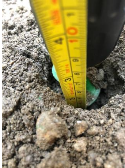
Figura 37-Profundidad de agujero de 4cm.
