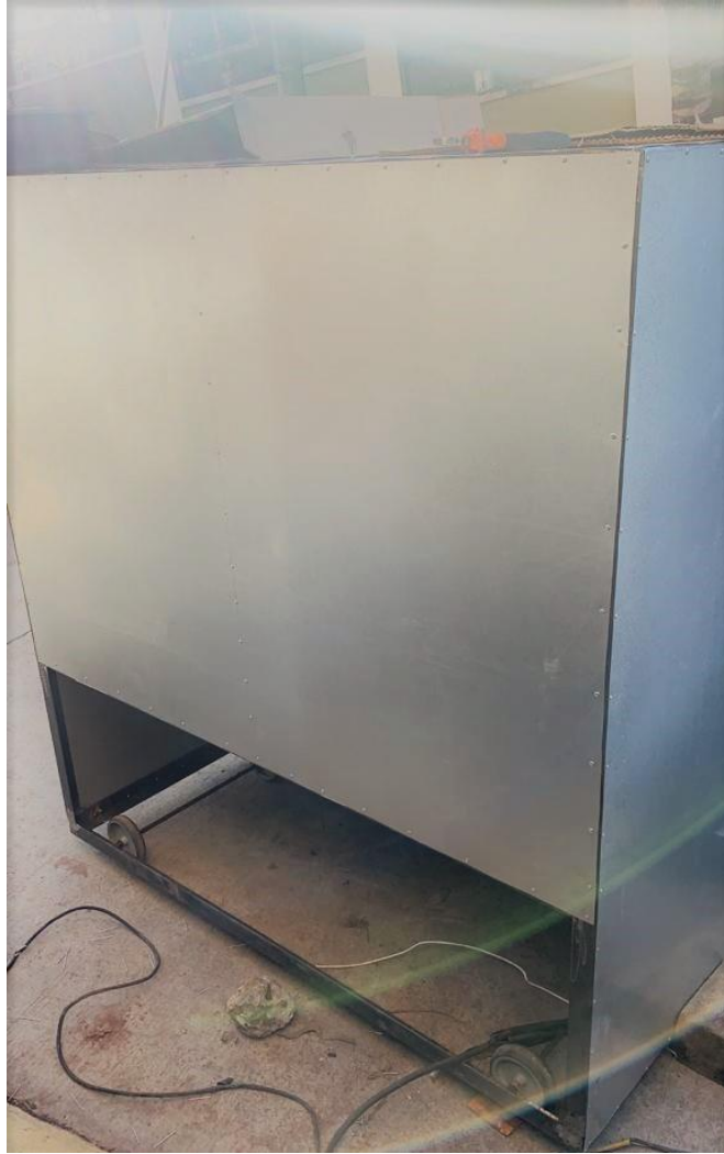
Ilustración 239: Instalación de lámina a sistema estructural
