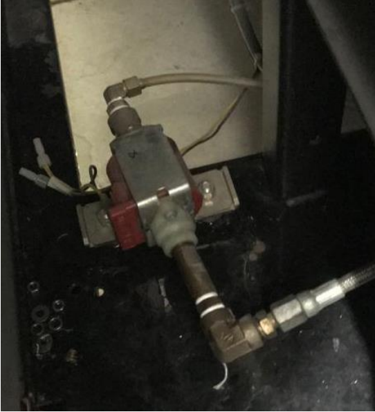
Ilustración 26. Bomba de agua de esterilizador a vapor
