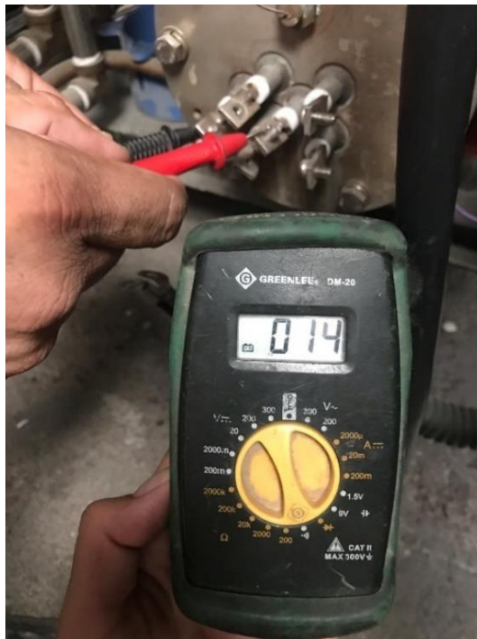
Ilustración 21. Medición de impedancia y continuidad de resistencia
