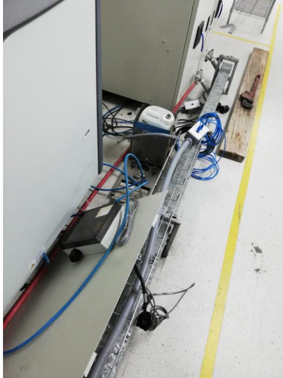
Ilustración 52. Cableado de la línea.
