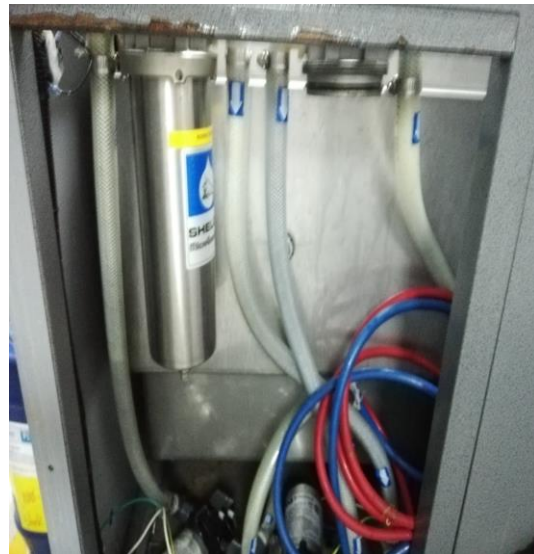
Ilustración 46. Cambio de filtros.
