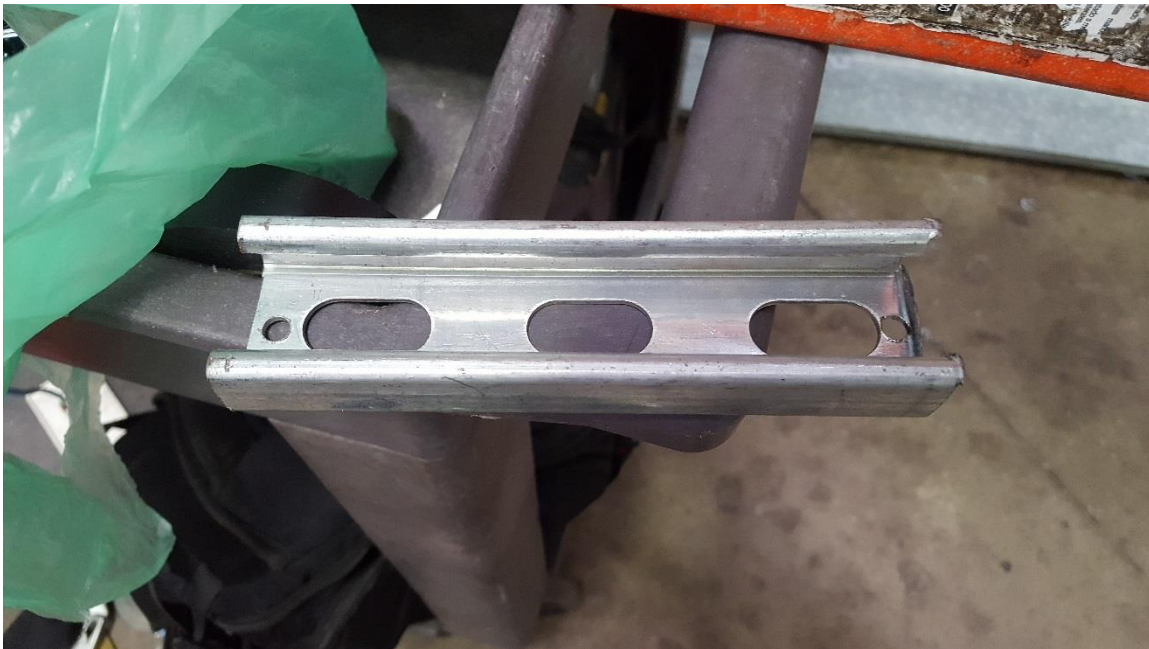
Ilustración 16. Soporte para tubería, Riel Strut del bajo
