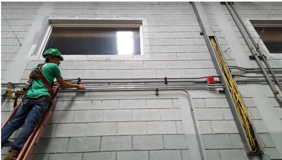
Ilustración 14. Instalación de ramificación de tubería RMC en Bandeja Porta cable existente.
