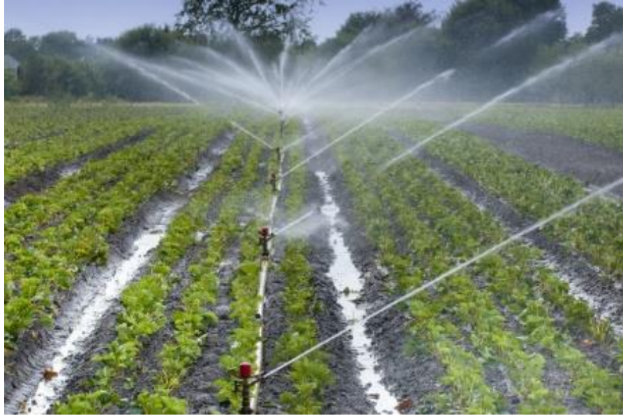
Ilustración 24. Sistema de riego fijo por aspersión
