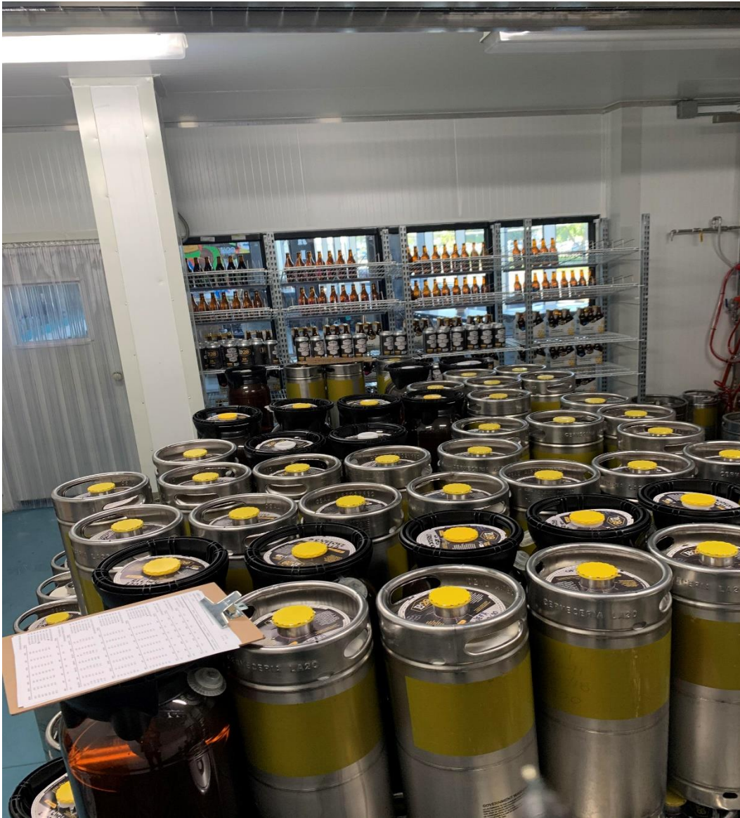
Figura 13: Cuarto frio Cervecería La 20 (Fuente Propia)
