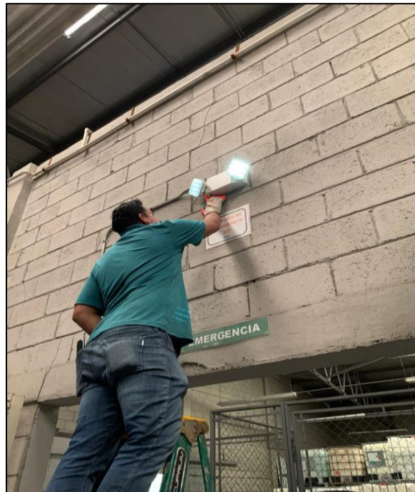
Ilustración 9 Inspección de lámparas de emergencia
