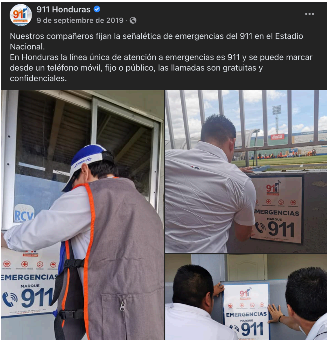
Ilustración 16. Instalación de la señalética de 911.
