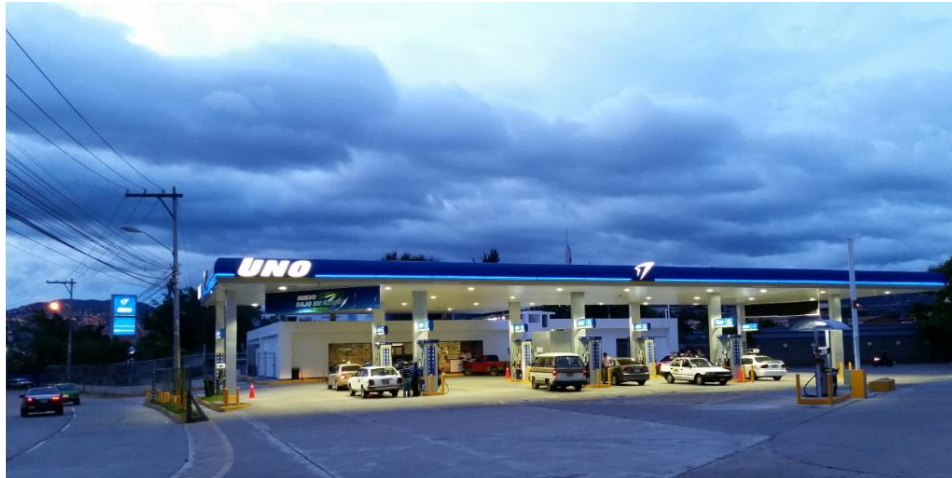
Figura 11. Estación de Servicio UNO Kuwait Operacional
