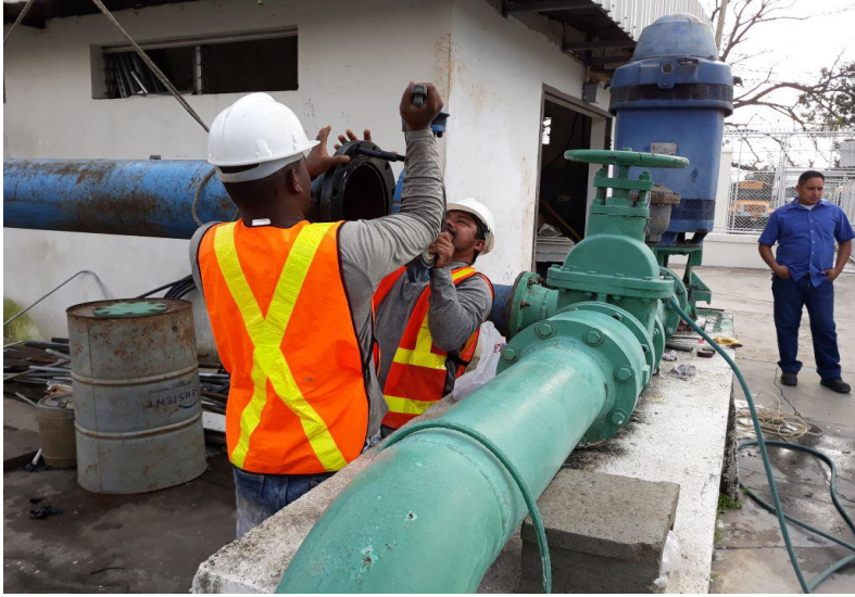
Figura 9. Empleados de la empresa IWS ejecutando trabajo en maquila Elcatex Fuente: Propia (2019)
