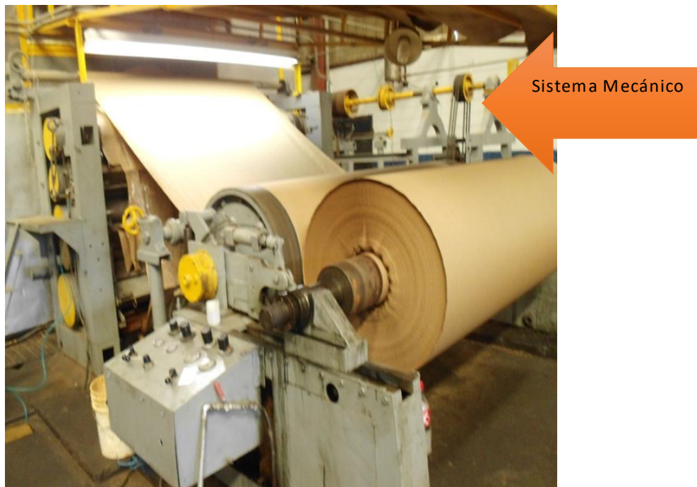
Figura 46. Instalación de los nuevos motores
