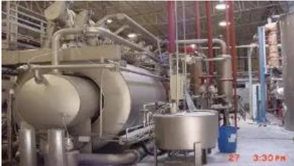
Figura 22. Tintorería en Elcatex
