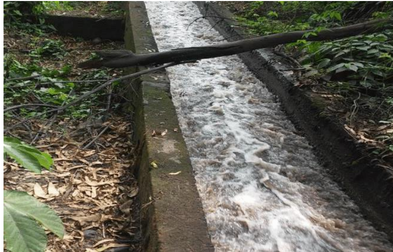
Figura 18: Canales de desagüe del proceso de lavado de caña
