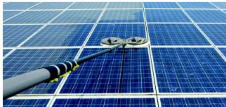
Figura 32. Mantenimiento Paneles solares
