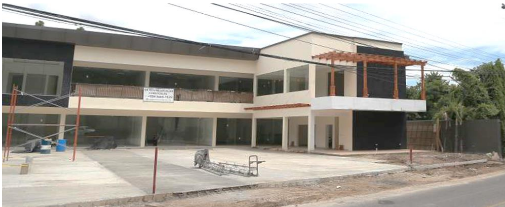
Figura 67. Construcción de plazas en Villas Mackay.
