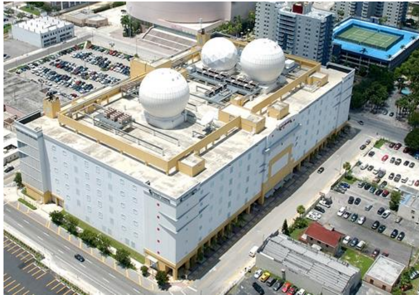
Figura 7. Instalaciones del NAP de las Américas
