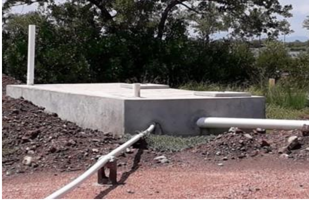
Figura 25. Fosa séptica de planteles Fuente: GGMSA
