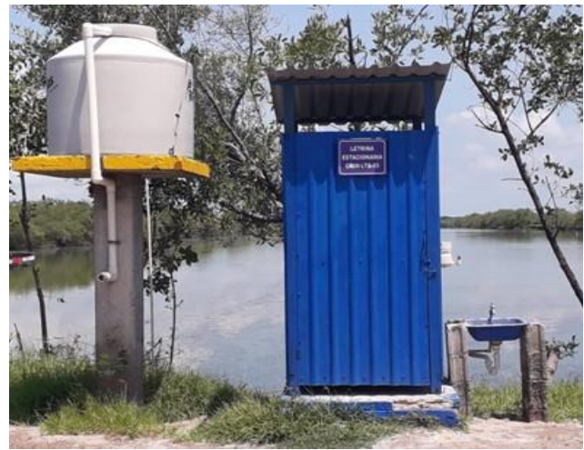
Figura 28. Letrina estacionaria Fuente: GGMSA
