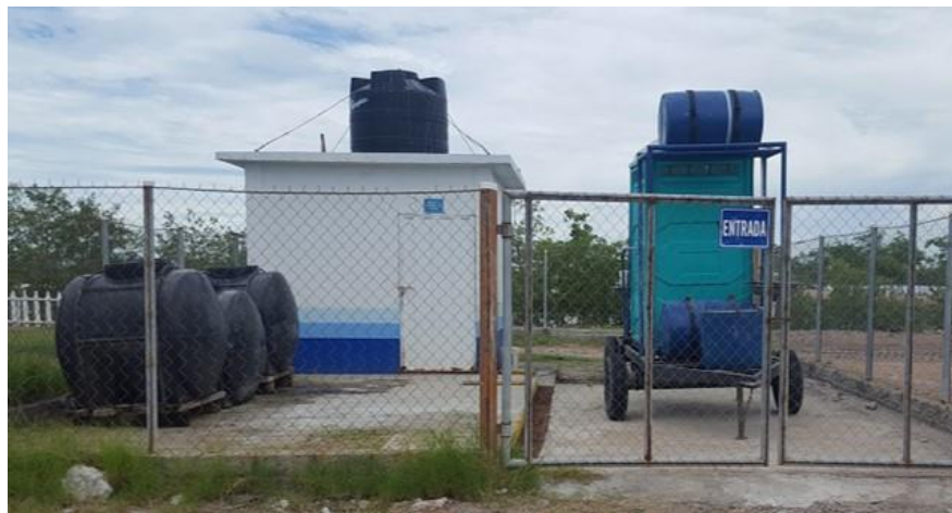
Figura 29. Vista de entrada de centro de sanitización Fuente: GGMSA
