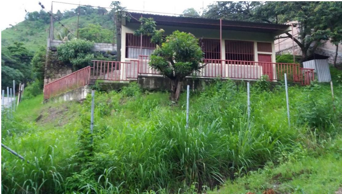
Figura 2. Fotografía de actual centro comunal de la colonia Brasilia
