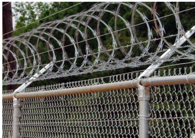
Figura 26. Seguridad Perimetral Razon Ribbon.
