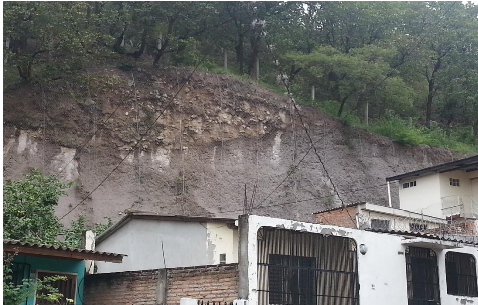
Figura 29. Proyecto Construido en Residencial Las Fuentes.
