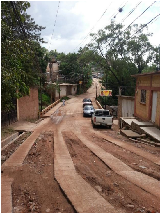
Figura 27. Proyecto Construido en colonia Villanueva
