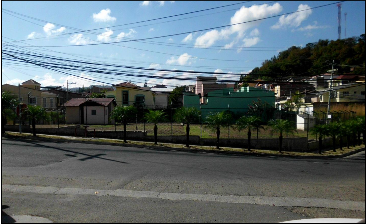
Figura 26. Vista frontal del terreno.
