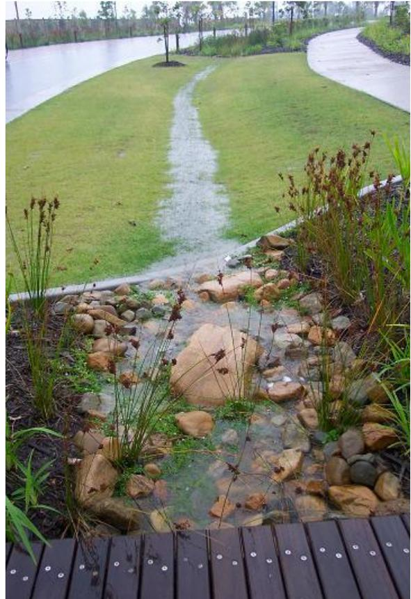
**Figura 29. Medidas para infiltración del agua lluvia en el terreno y disminuir la cantidad hacia la red pública**
