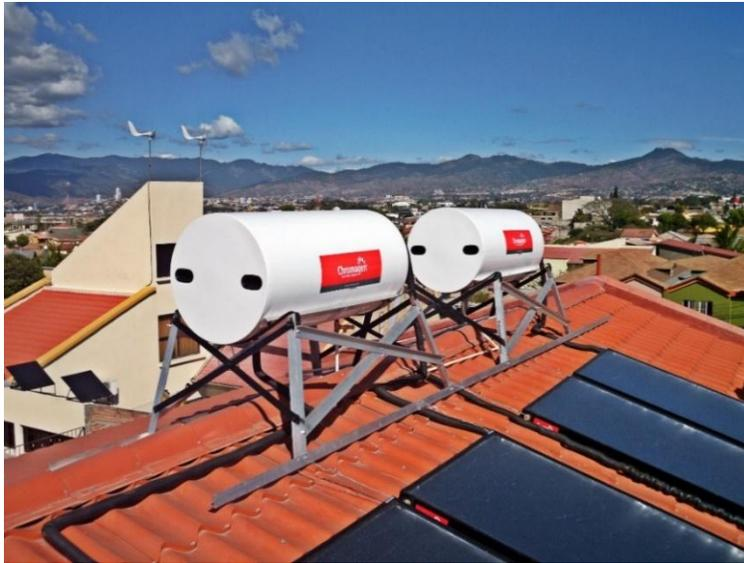
**Figura 21. Calentadores de agua con energía de paneles Solares**
