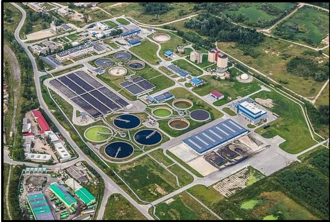
Figura 3. Planta de tratamiento de agua residual en México
