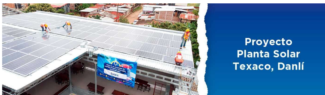
Figura 38. Instalación de paneles en techo de estación Texaco, Danlí.
