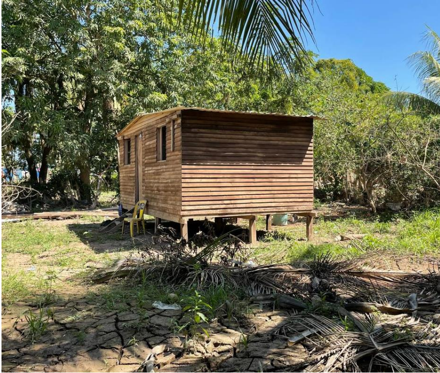
Figura 46. Casa en la comunidad que fue reconstruida y elevada.
