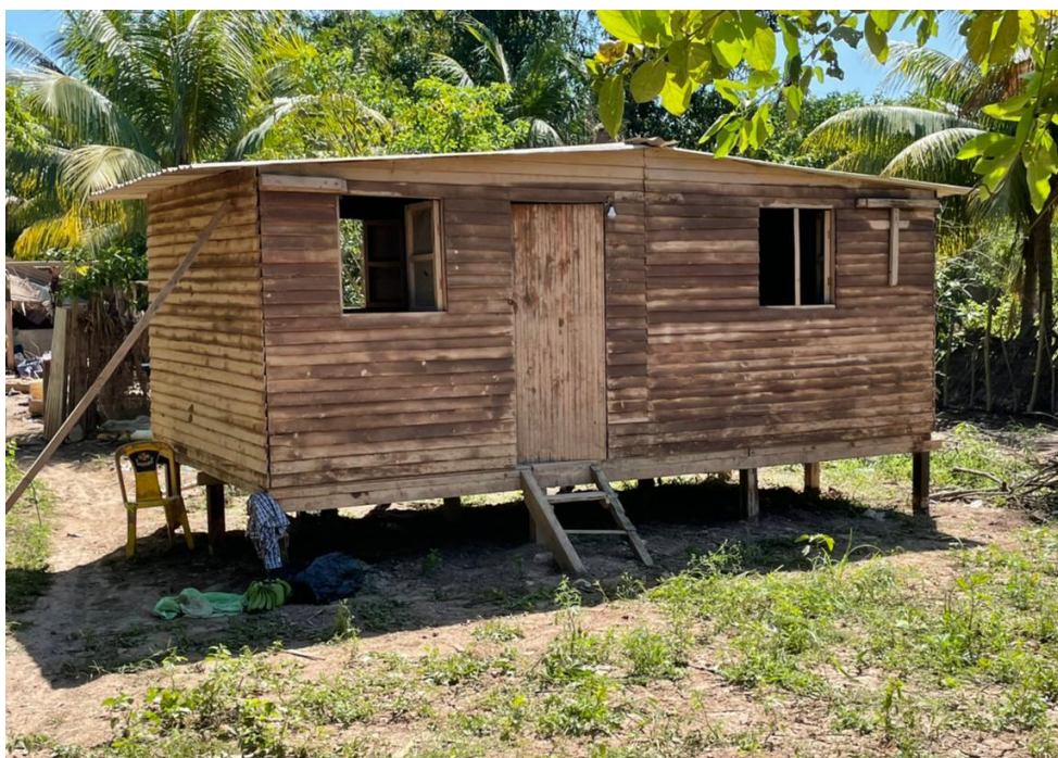
Figura 48. Casa que fue reconstruida por sus habitantes después de los huracanes.
