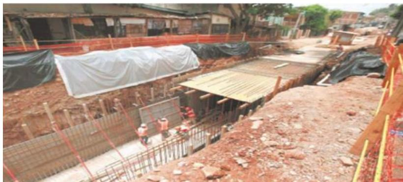
**Figura 21: Ilustración típica de un embaulado**
