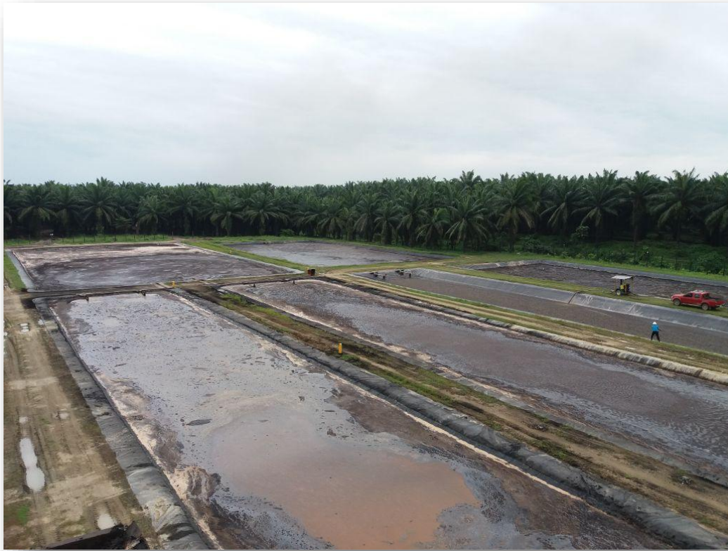
Figura 12: Lagunas de oxidación
