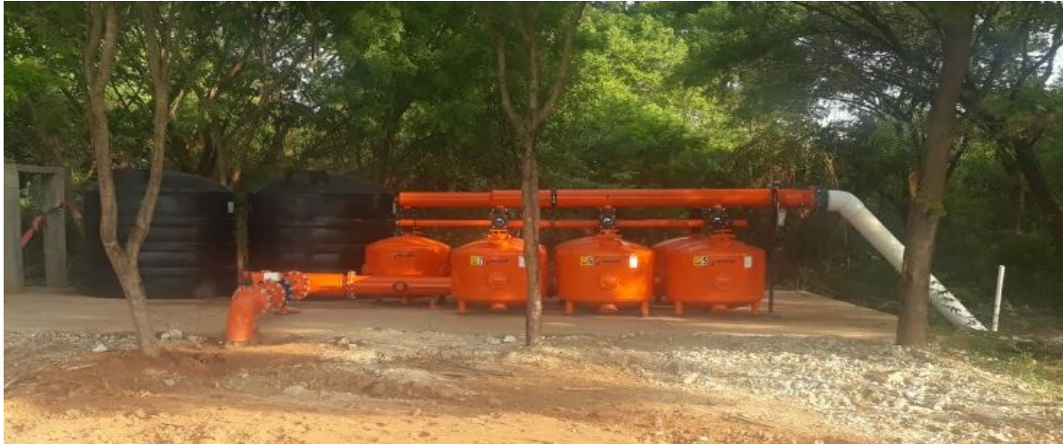
Figura 29 Filtros de grava en sistema de riego goteo
