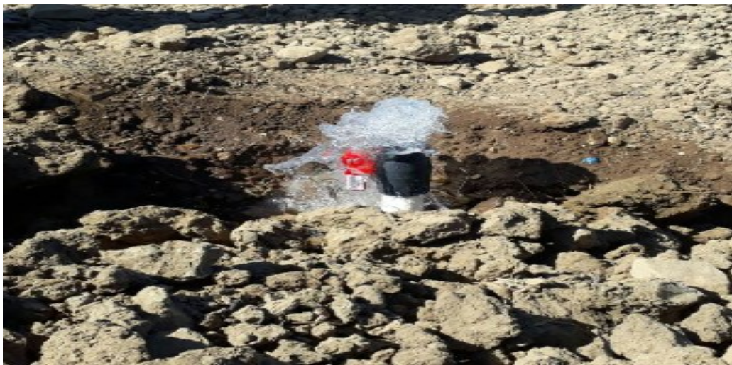
Figura 34 Drenaje de agua del sistema de goteo
