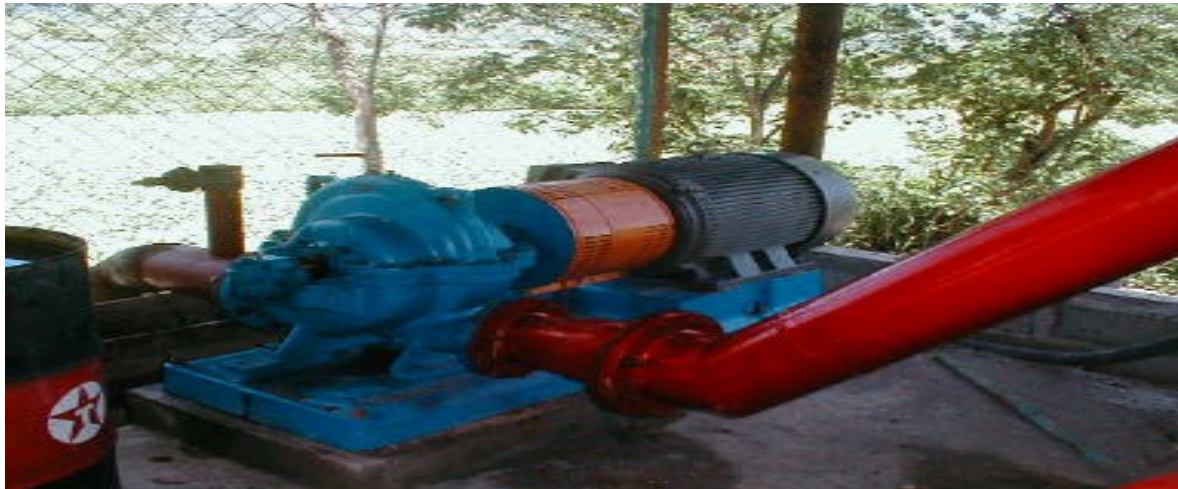
Figura 23 Bomba eléctrica carcasa partida
