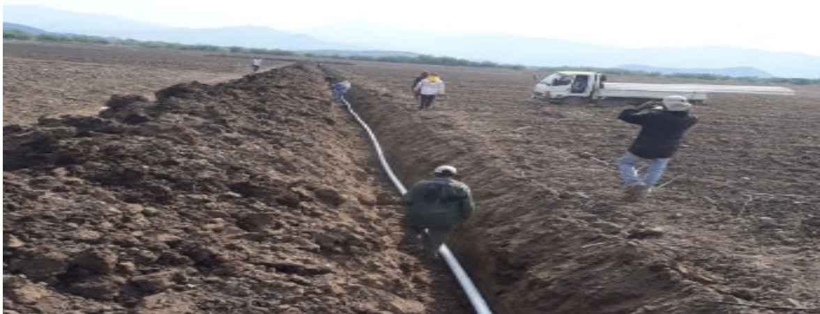
Figura 25 Instalación de tubería secundaria
