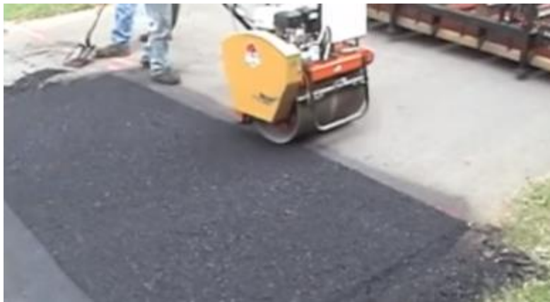
Figura 21: Compactación de la zona
