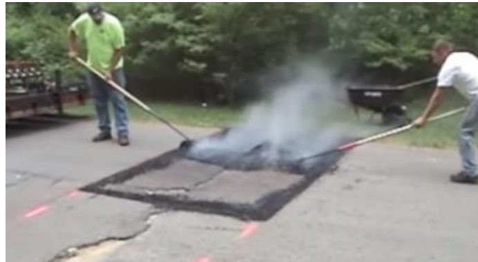
Figura 19: Escarificación de la zona
