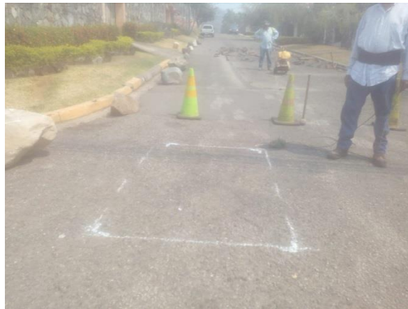
Figura 10: Marcación del área identificada
