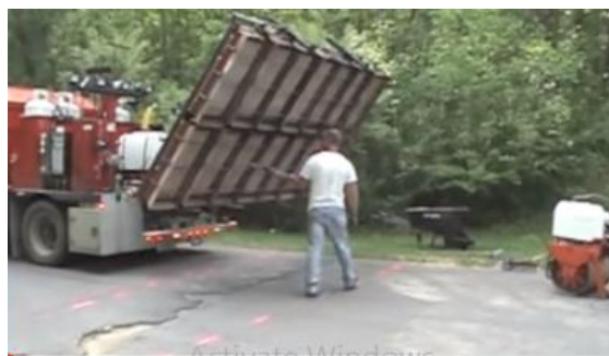
Figura 17: Movilización de la maquina calentadora de asfalto
