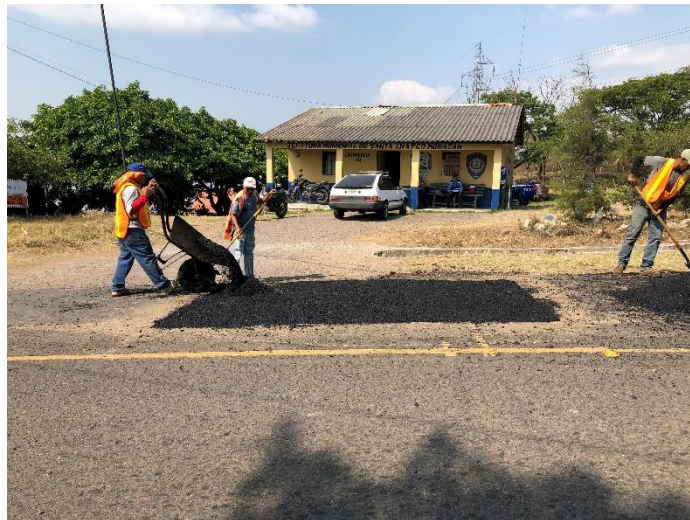
Figura 14: Colocación del asfalto
