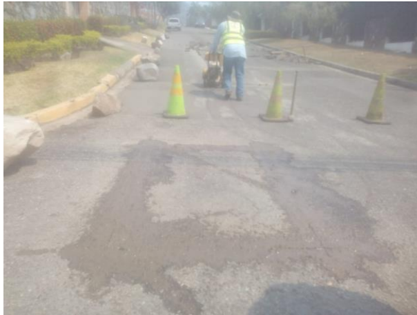
Figura 9: Identificación de la zona deteriorada
