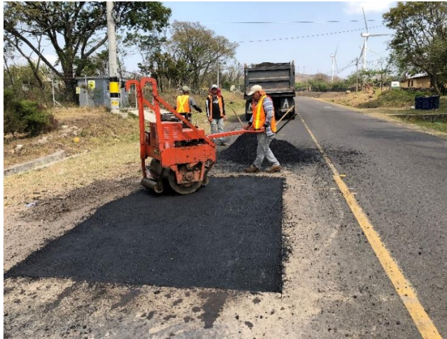
Figura 15: Compactación de la nueva carpeta
