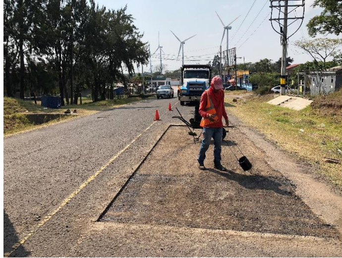
Figura 13: Imprimación del área
