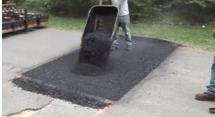
Figura 20: Colocación de mezcla asfáltica
