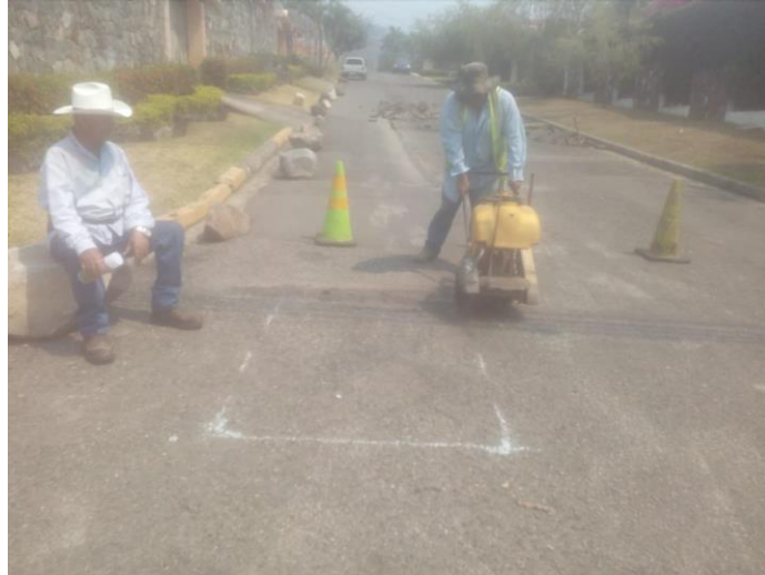
Figura 11: Corte Del área marcada
