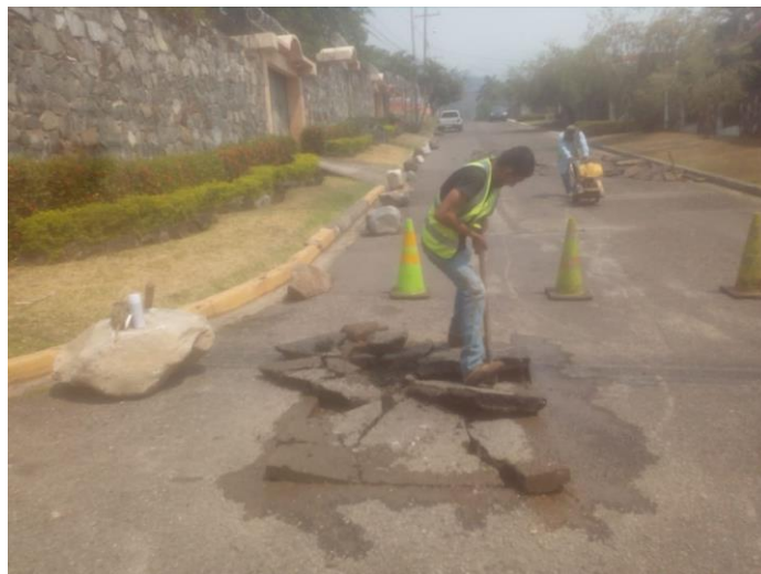
Figura 12: Excavación del área cortada
