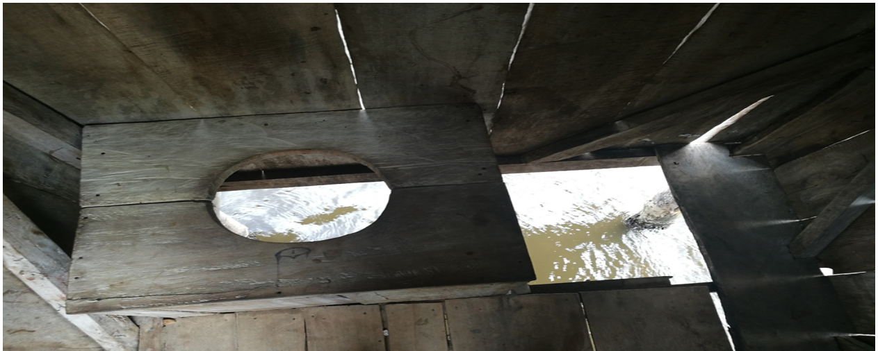
Foto 6. Módulo Sanitario existente en Escuelas en zona de La Mosquitia.
