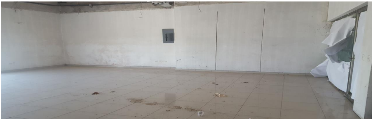
Figura 33 - Vista del local lado derecho – Imagen propia
