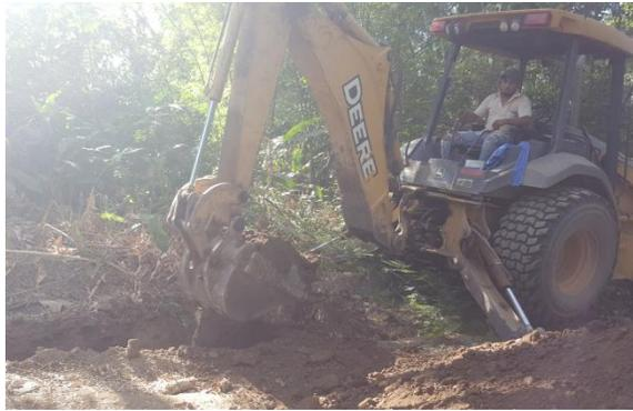
**Figura 28. Excavación para tuberías**
