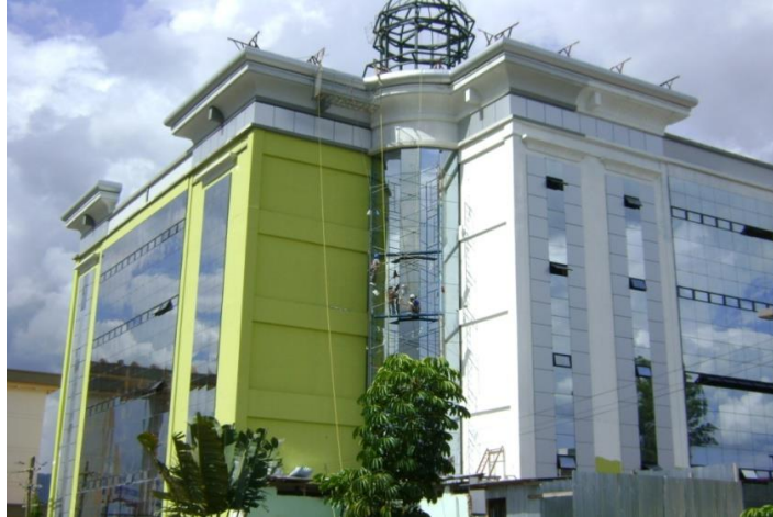
Figura 20. Edificio Administrativo INPREMA, Tegucigalpa M.D.C.
