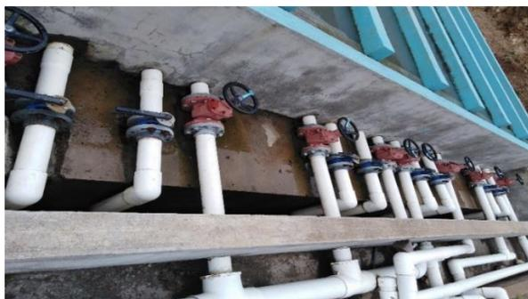
**Figura 25. Válvulas de lavado y válvulas de control de caudal.**
