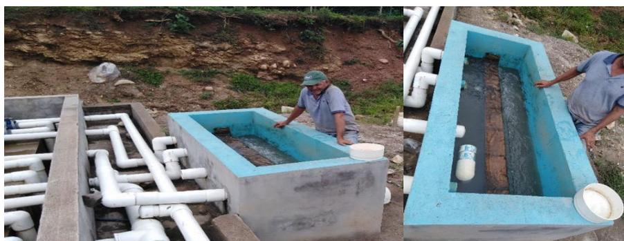
**Figura 26. Pila de concentración de caudal.**
