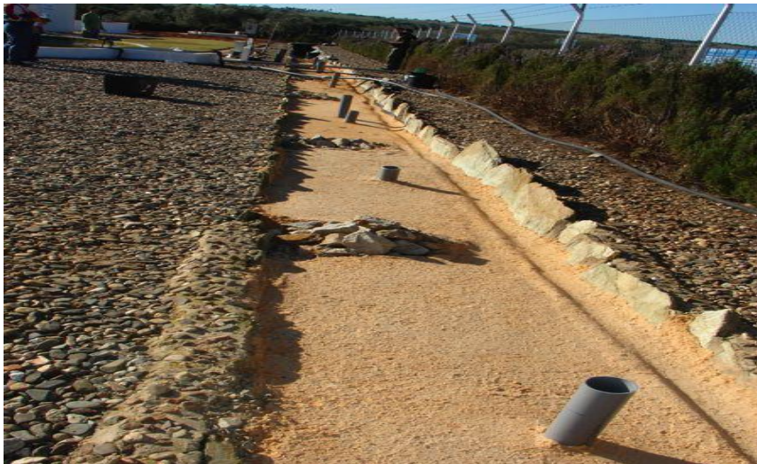
Figura 23. Canal Sellado Terminado con sus Aireadores
