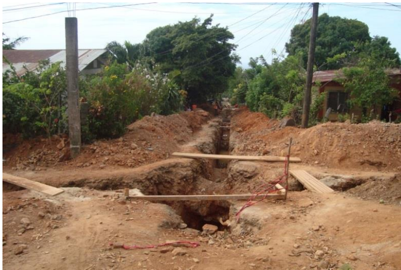
Figura 17. Construcción de Red Colectora de Aguas Residuales Trujillo Colon Proyecto FHIS.
