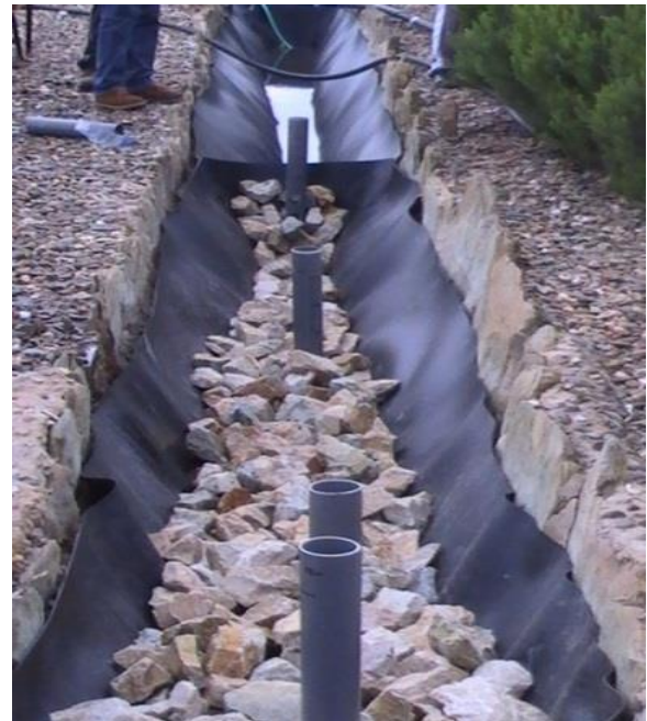
Figura 22. Canal con Dren de Piedra
