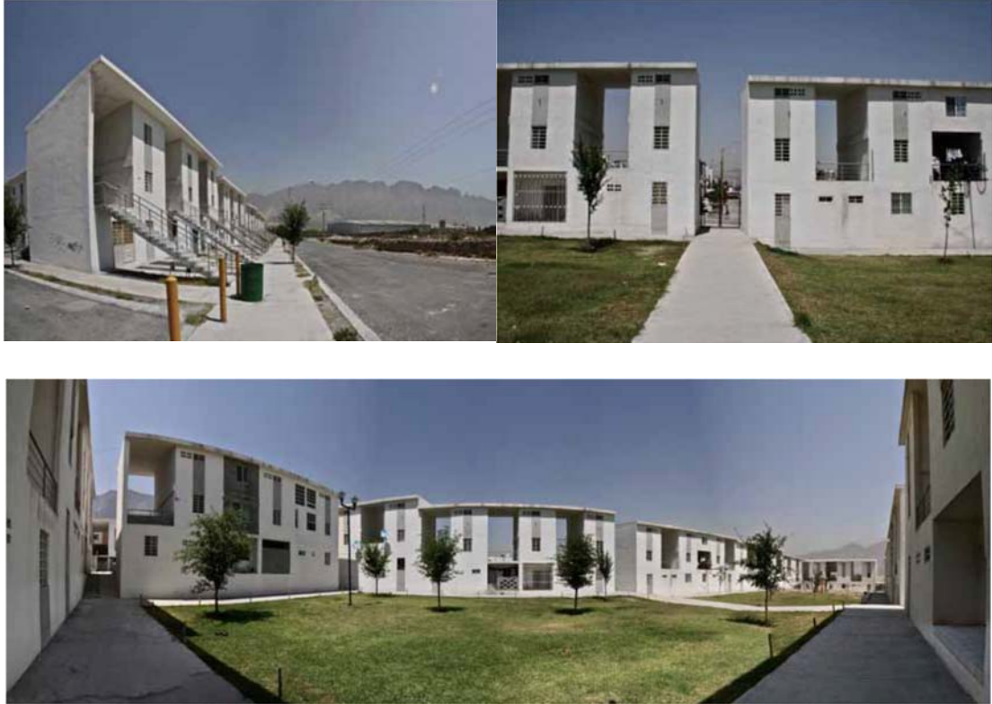
Figura 7. Viviendas tipo Dúplex, Nuevo León, México.
