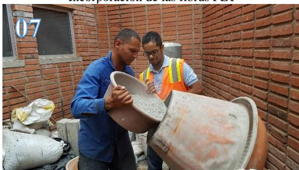
Incorporación de cemento y agua de mezclado
