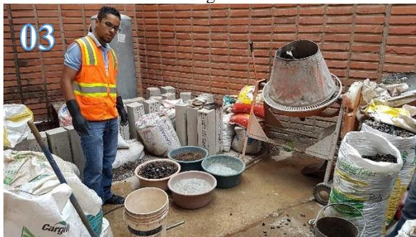
Materiales medidos para la mezcla colocados en recipientes (pailas) para facilitar su manipulación
