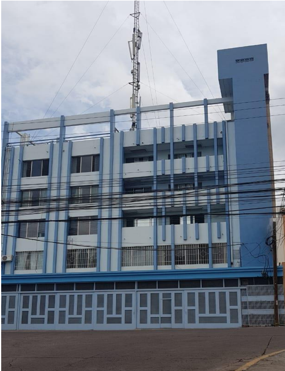
Figura 18. Fachada Actual del Edificio
