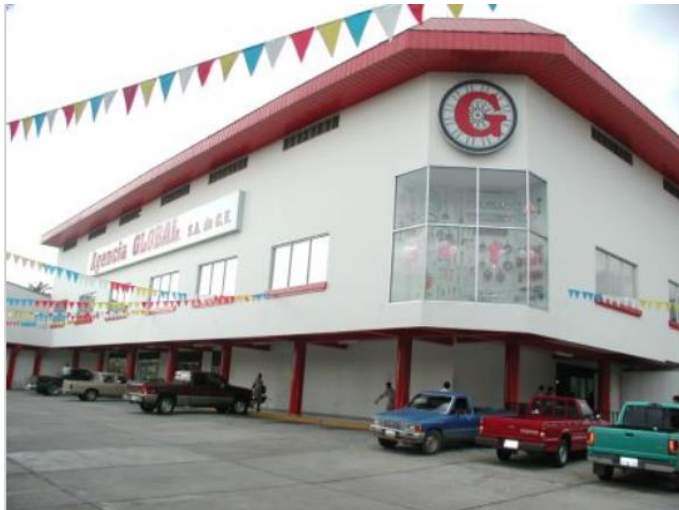
Figura 11. Fachada principal de Agencia Global
