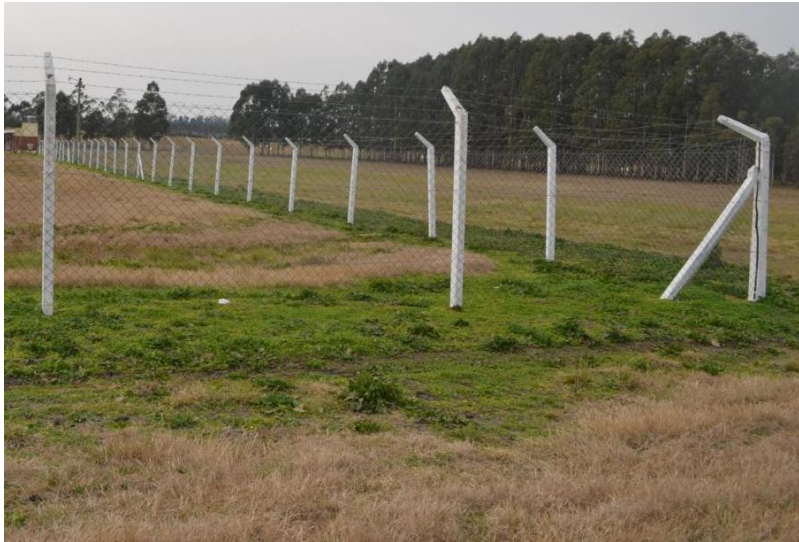
Figura 35. Cerco perimetral de alambrado olímpico
