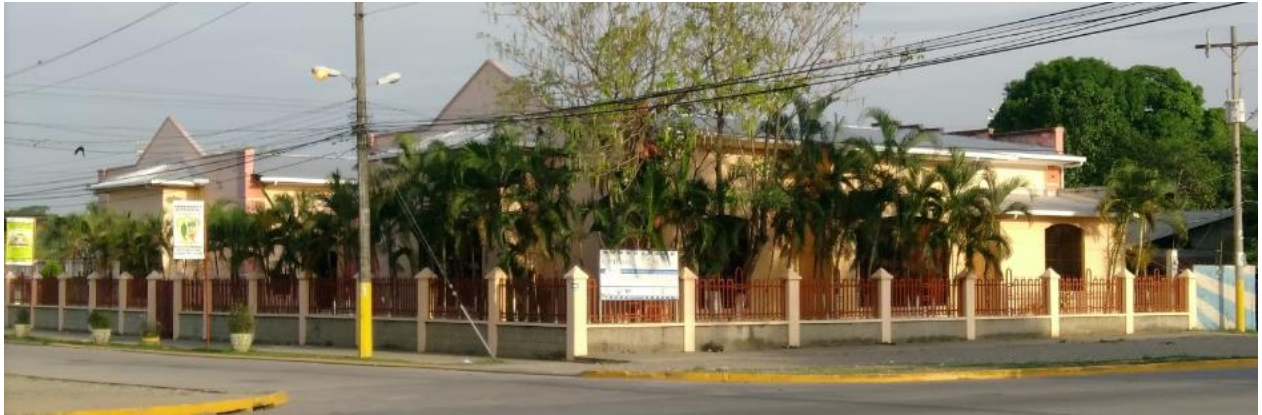
Ilustración 28 Casa de la Cultura El Progreso
