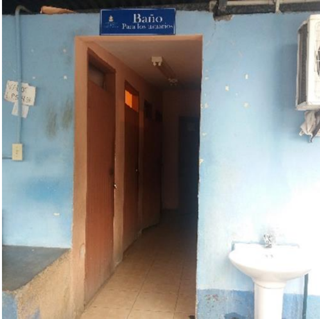
Área de baños, en los cuales se cobran Lps 4.00 para su uso.
