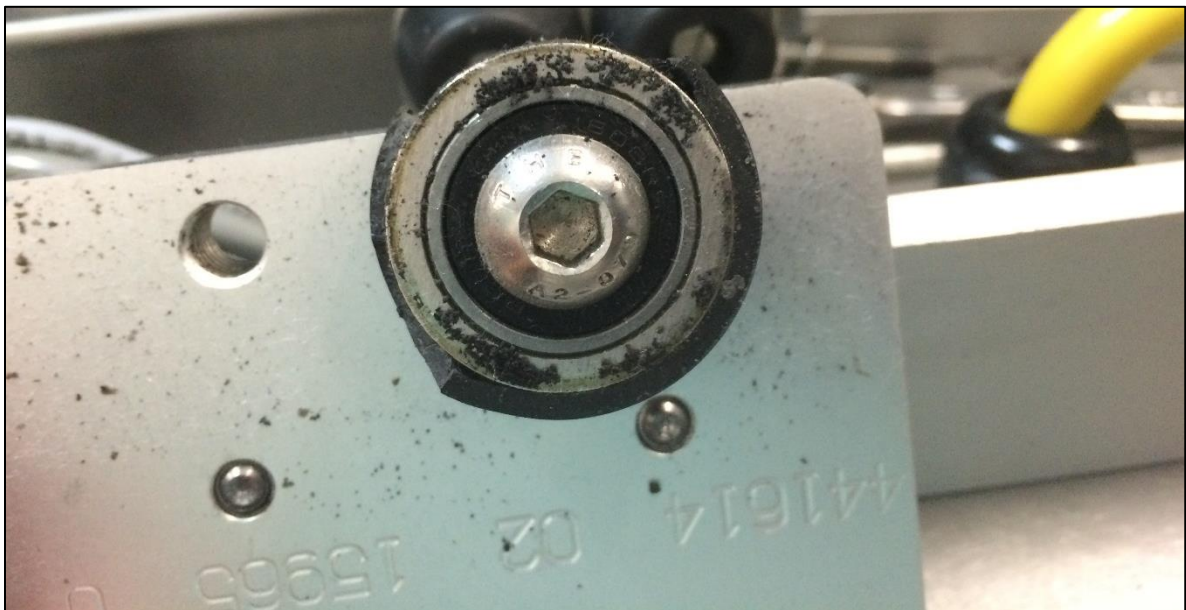
Rodo de Hule totalmente desgastado.
