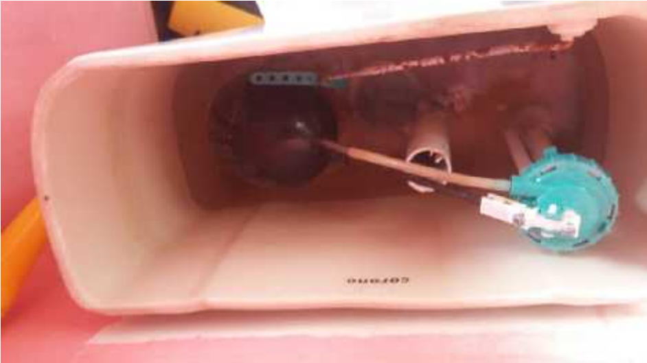
Figura 30. Conexión de prueba de presión de agua hacia los tanques sanitarios
