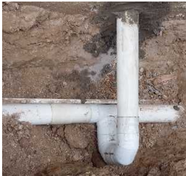
Figura 24. Conexión y desconexión de tubería
