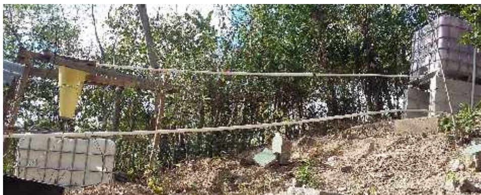
Figura 29. Unión de tanque 1 y tanque 2
